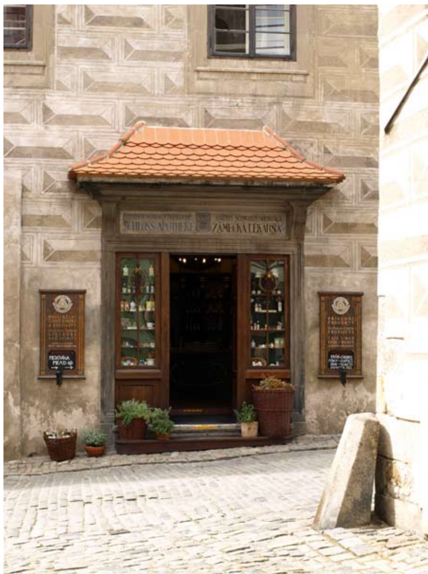
Ilustracja 2 Portal kamienicy mieszczącej „Nową” aptekę „Zamkową”. Zdjęcie autora.
